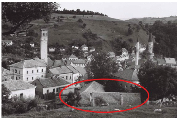
Prilog 10. Fotografija krova obnovljene medrese.
