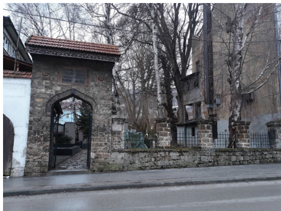
Prilog 8. Kapija i dio ogradnog zida nekadašnjeg kompleksa medrese.
